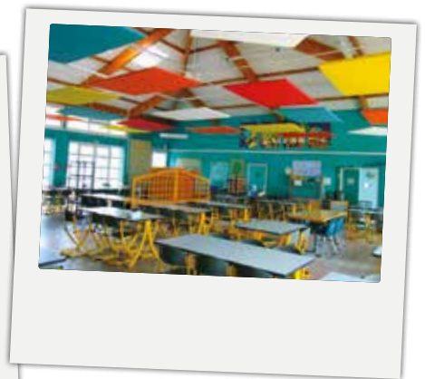
■ Mardi 28 août : le restaurant scolaire prêt pour la rentrée après l'installation des panneaux d'insonorisation au plafond.
