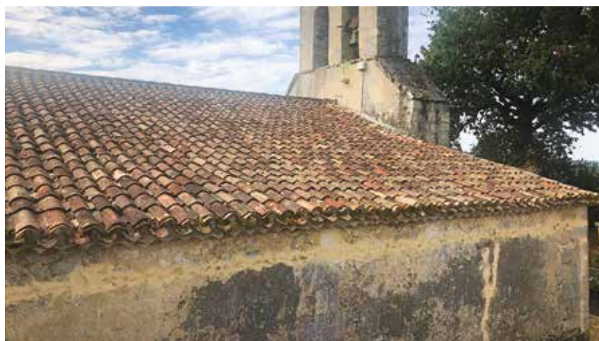
Les travaux réalisés ont pour but de consolider l'édifice qui s'érode avec le temps. A l'arrière de la chapelle, depuis le parking, l'emplacement du tirant de 12 mètres est visible en haut du mur, juste sous la toiture, là où les enduits sont récents.
