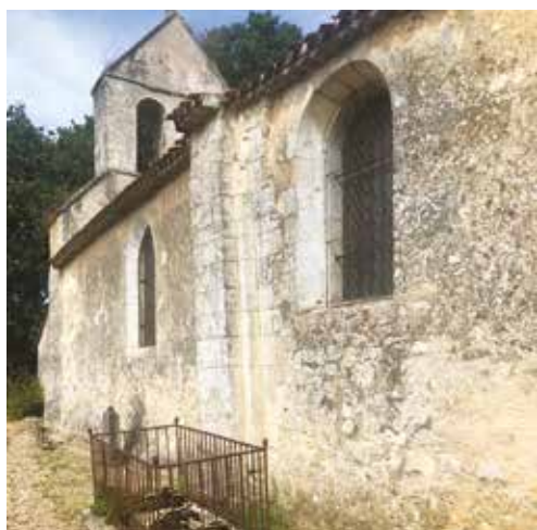
Les travaux réalisés ont pour but de consolider l'édifice qui s'érode avec le temps. A l'arrière de la chapelle, depuis le parking, l'emplacement du tirant de 12 mètres est visible en haut du mur, juste sous la toiture, là où les enduits sont récents.
