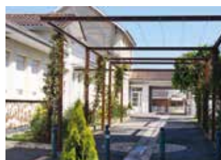
Cadre de vie : création d'une pergola végétalisée chemin des Écoliers.
