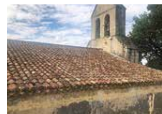
Patrimoine : travaux de réfection à la chapelle de Meynac.
