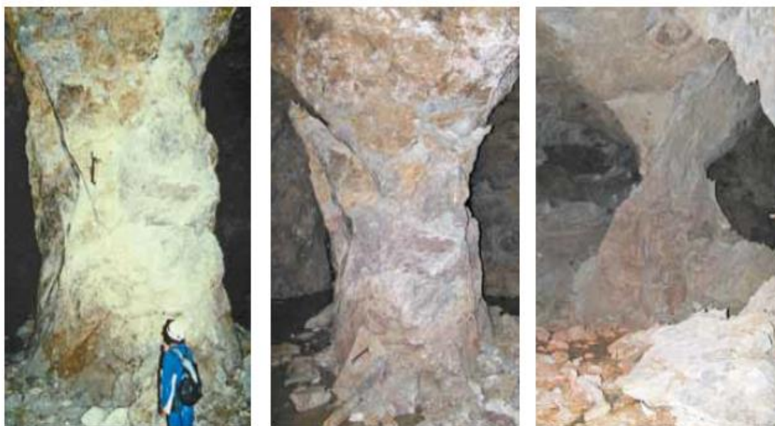
Vues d'un même pilier en 1996, 2000 et 2005 (INERIS)
