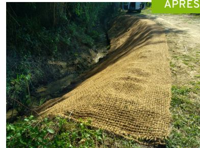
Suppression d'un seuil racinaire & restauration de la berge sur le Mansin.
