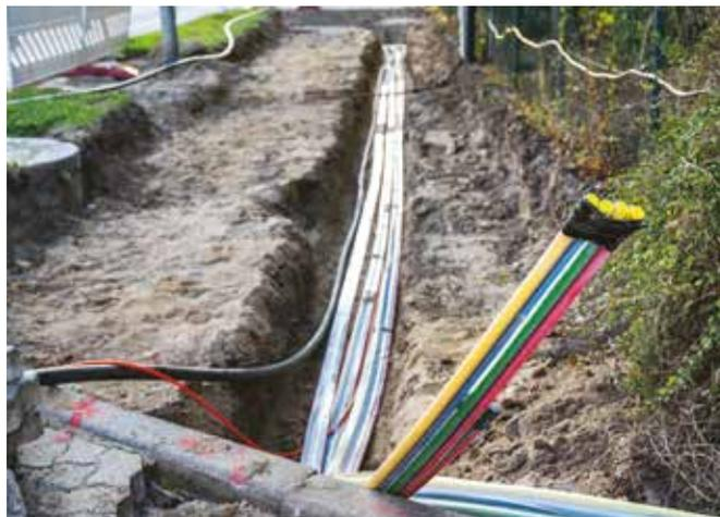
**la fibre optique des armoires de rue, à déployer la fibre en souterrain dans les fourreaux ou en aérien sur des poteaux existants ou remplacés.**
